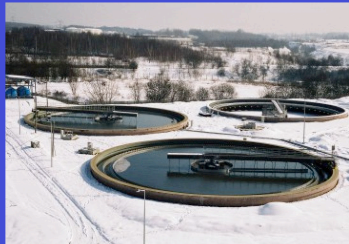
Die Kläranlage CENTRALNA in Beuthen, erbaut mit Fördermitteln der Europäischen Union
